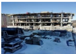
Строительство монолитного каркасного здания с переходным этажом
