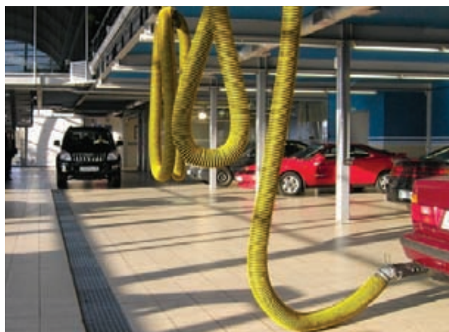
Системы удаления выхлопных газов
