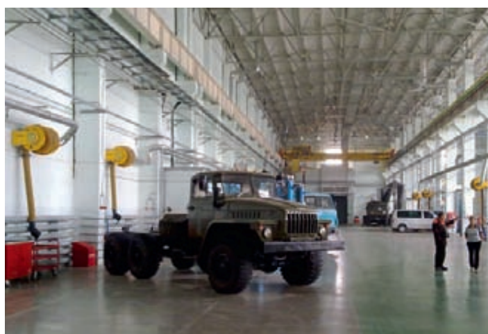
Применение вытяжных катушек с механическим приводом SER-P для оснащения гаражей и закрытых стоянок грузовой спецтехники
