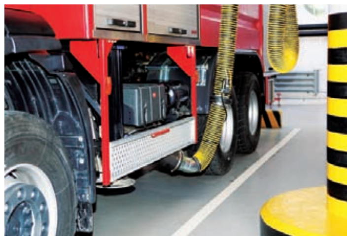
Специализированная пневматическая газоприемная насадка с автоматическим отсоединением при выезде автомобиля из бокса
