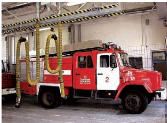
Системы удаления выхлопных газов от пожарного АТ и спецтехники
