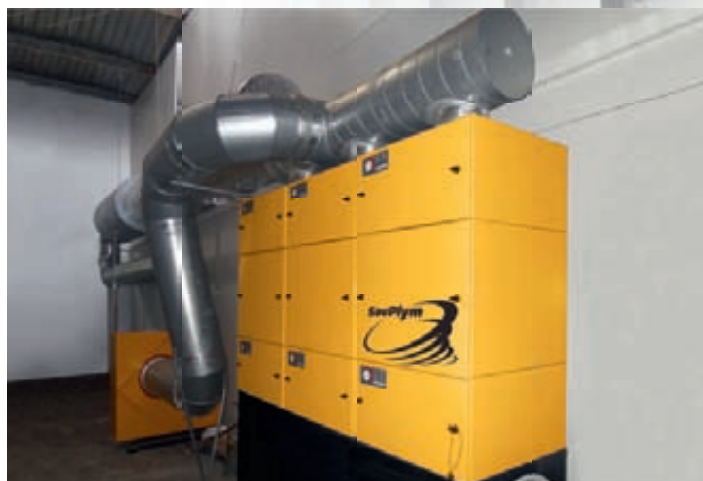
Модульный фильтр масляного тумана ME
