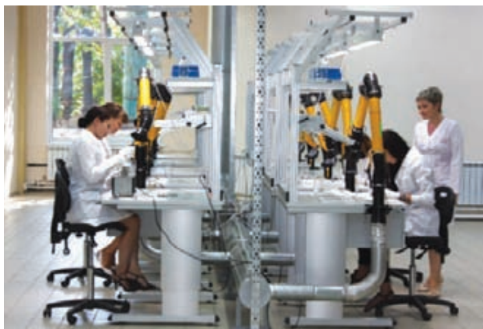
Пример подключения настольных вытяжных устройств к центральной вытяжной системе
