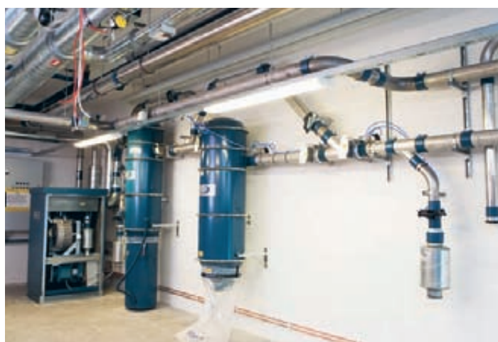
Центральная высоковакуумная система для пылеуборки
