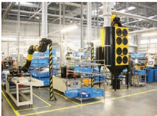
Системы местной вытяжной вентиляции
