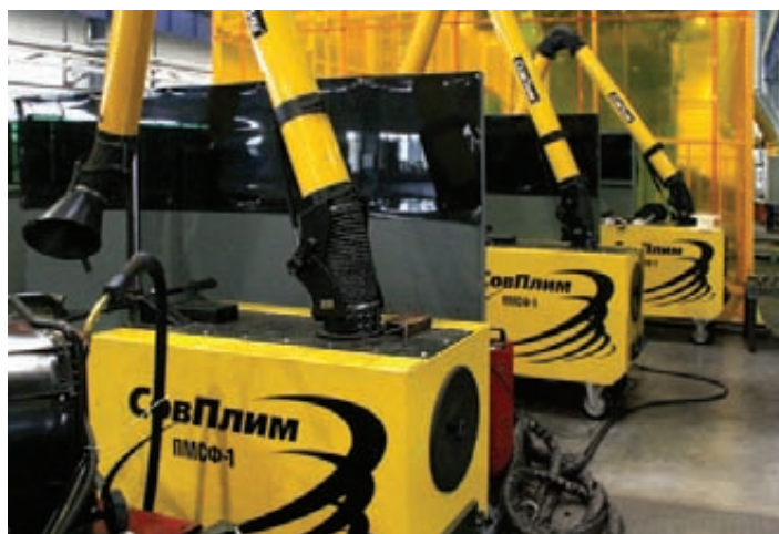
Передвижные агрегаты ПМСФ на участке временных сварочных постов
