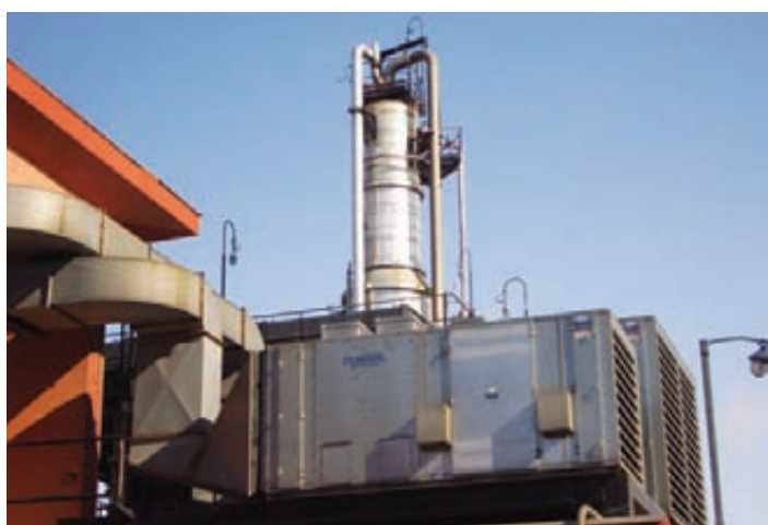
Очистка удаляемых газов до ПДВ
