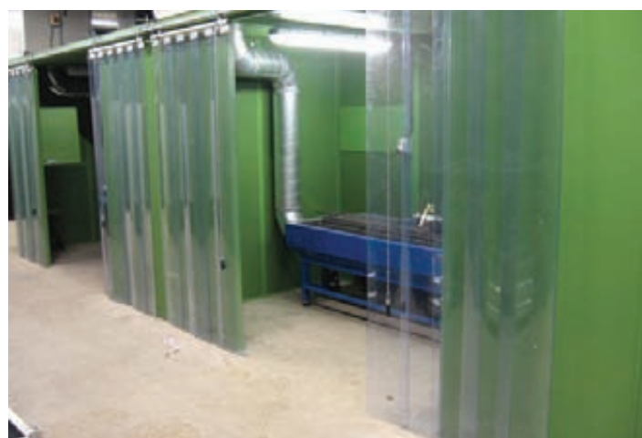
Участки зачистки и шлифовки
