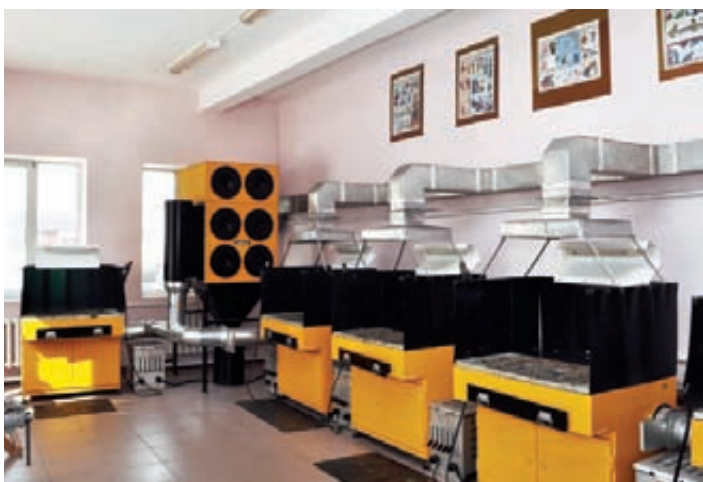
Сварочно-зачистной участок, оборудованный центральной системой удаления и очистки воздуха
