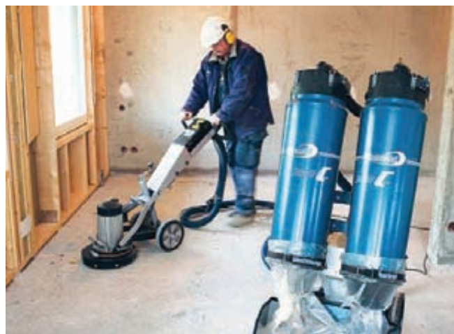
Высоковакуумное пылеудаление и пылеуборка
