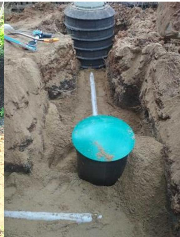
5. После засыпки септика песком (до уровня входа в септик) и заполнения его водой можно производить подключение труб канализации (вход и выход), силового кабеля(при подкл. дренажного насоса). Вход в септик при стандартной комплектации предусмотрен на уровне 600мм. Если отводящая труба уже проложена ниже уровня, необходимо нарастить горловину добором (не более 1000мм). Затем, осуществляется полная засыпка песком. Крышка горловины септика должна выставляться над поверхностью земли на 50-100м.
