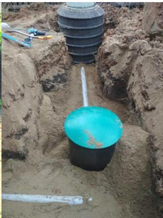
5. После засыпки септика песком (до уровня входа в септик) и заполнения его водой можно производить подключение труб канализации (вход и выход), силового кабеля (при подкл. дренажного насоса). Вход в септик при стандартной комплектации предусмотрен на уровне 600мм. Если отводящая труба уже проложена ниже уровня, необходимо нарастить горловину добором (не более 1000мм). Затем, осуществляется полная засыпка песком. Крышка горловины септика должна выставляться над поверхностью земли на 50-100мм.
