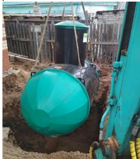
4. Засыпка пазух между стенками котлована и септика производится не вынутым грунтом, а песком без крупных твердых включений с одновременным постепенным заполнением септика водой до уровня нижнего края выходной трубы. Засыпка септика производится вручную.
