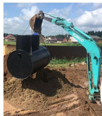
4. Засыпка пазух между стенками котлована и СБО производится не вынутым грунтом, а песком без крупных твердых включений с одновременным постепенным заполнением СБО водой до уровня нижнего края выходной трубы. Засыпка СБО производится вручную.
