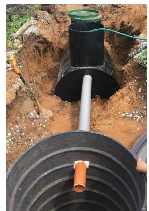
**Запрещается:** сбрасывать очищенную воду из ЛОС на открытые поверхности грунта, т.к. это приведет к намерзанию льда на выходе труб, что заблокирует выход воды из ЛОС и приведет к переполнению СБО. Так же запрещено отведение воды в открытые глинистые грунты, во избежание заиливания местности.
