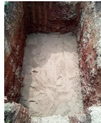
2. Котлован для СБО копается таким образом, чтобы его размеры превышали габариты ЛОС на 120-250 мм по периметру и 100мм в глубину. Дно котлована выравнивается, обсыпается песком и трамбуется. Толщина песчаного основания должна быть минимум 100 мм.
