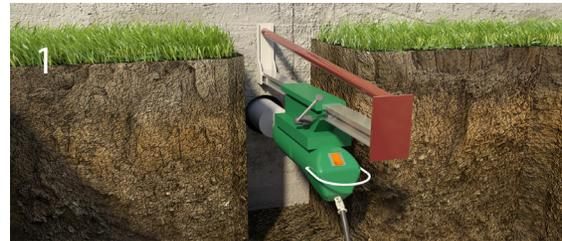
Алмазное сверление фундамента для прокладки канализационного трубопровода.
