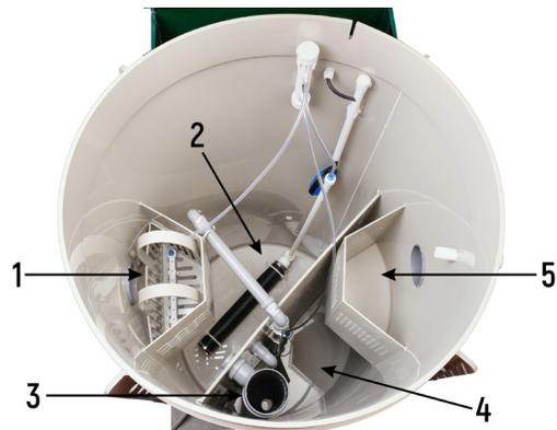
**3 блок:** успокоитель ила и **4 блок:** вторичный отстойник - обеспечивают эффективное разделение активного ила и очищенной воды, обеспечивают поддержание стабильного количества ила, что необходимо для окислительной способности системы, для этого осуществляется постоянный рецикл во второй блок установки. Избыточный ил удаляется несколько раз в год.
