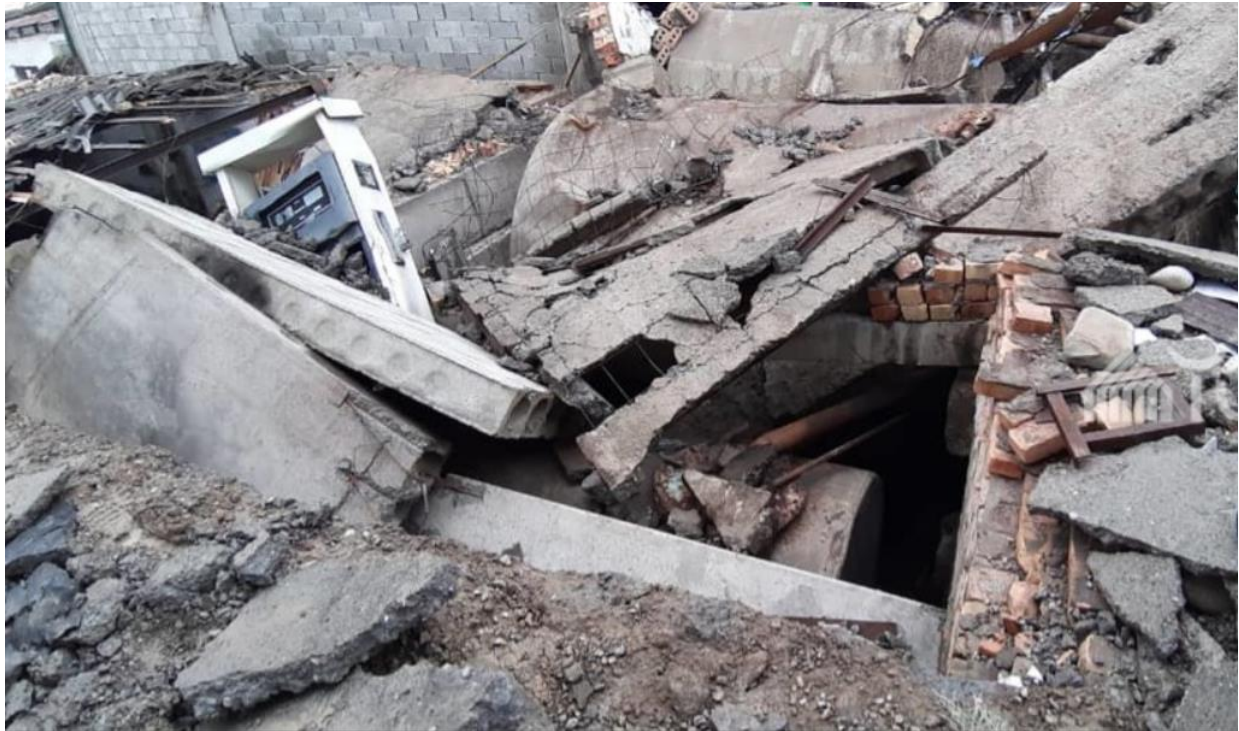
Рисунок 4. Состояние резервуара АЗС «Октан Сервис» после взрыва
