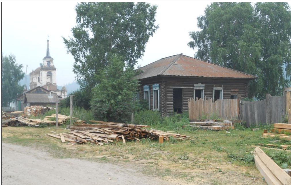
Здание бывшей начальной школы в с. Каменское, 2012 г.
