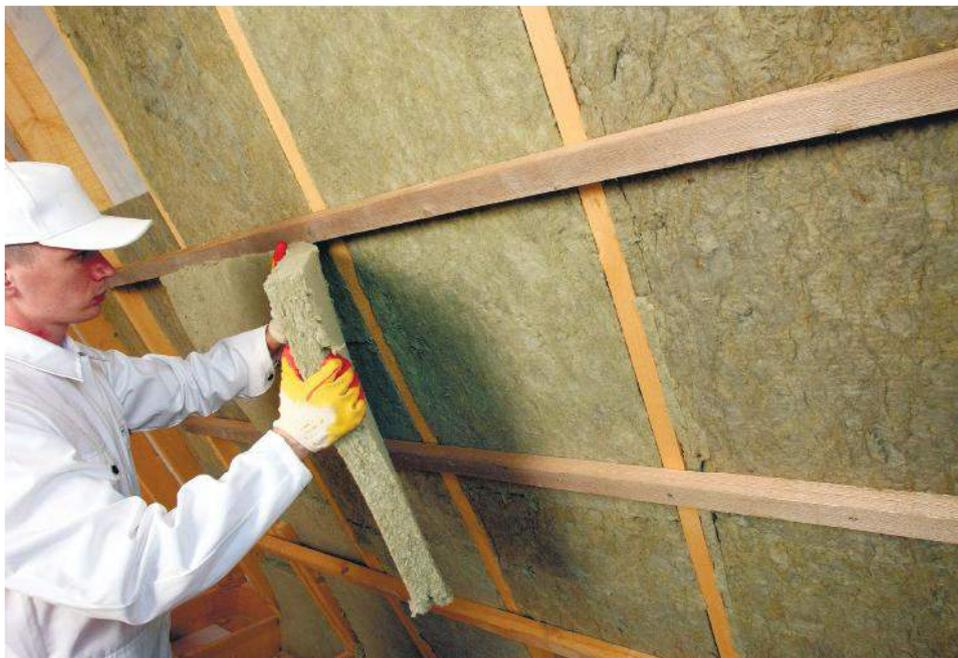
**КРЕПИМ НА СТЕНЫ ВЕРТИКАЛЬНУЮ ИЛИ ГОРИЗОНТАЛЬНУЮ ОБРЕШЕТКУ ИЗ БРУСКА. ШАГ РАВЕН ШИРИНЕ ВЫБРАННОГО УТЕПЛИТЕЛЯ: 60 СМ ДЛЯ МИНЕРАЛЬНОЙ ВАТЫ И 50 - ДЛЯ ПЕНОПЛАСТА.**
