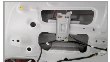
20. Установите звуковой излучатель, подключите «проходными» кабелями штатную кнопку открытия задней двери и штатный электрический замок
