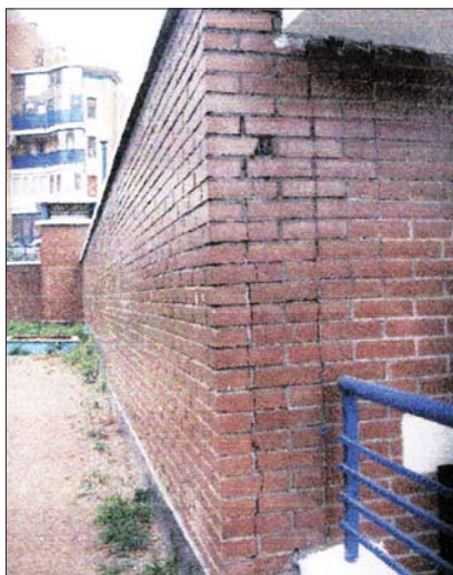
Рис. 2.3.9 д Температурные трещины в лицевом слое наружной стены одноэтажного въезда в гараж
