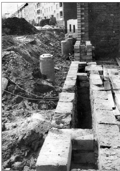
Рис. 1.1.13 Облегченная кладка наружной стены пятиэтажного жилого дома серии 85. (Волоколамское СМУ треста Мособлстрой-18) 1978 г. [9]
