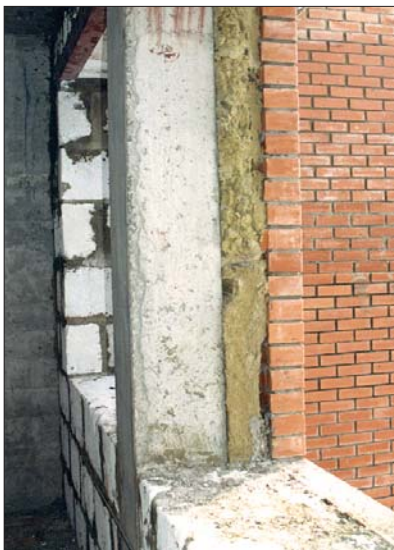
Рис. 1.1.23 д Установка эффективного утеплителя между лицевым слоем и железобетонной колонной
