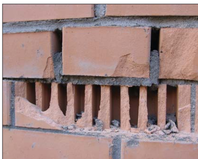
Рис. 2.3.7 к Растрескивание кирпичей лицевого слоя в уровне перекрытия над вторым этажом
