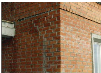
Рис. 2.3.4 Заполнение горизонтального деформационного шва кладочным раствором. Москва, 1999 г.
