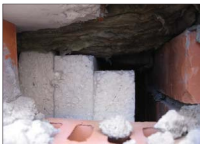
Рис. 2.2.1 г Неплотное прилегание плит утеплителя к низу плиты перекрытия (дом на ул. Петрозаводская). Фото автора, 2007 г.
