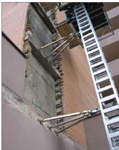
Рис. 2.3.7 л Ремонт кладки наружного (лицевого) слоя в месте образования вертикальных трещин
