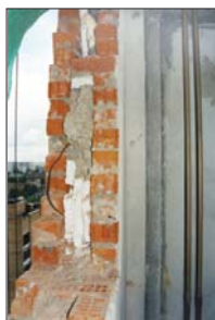
Рис. 2.2.1 а, б Пример некачественной укладки плитного утеплителя из пенополистерола в наружной стене: а – в месте примыкания наружного слоя к железобетонной колонне; б – в трехслойной кладке
