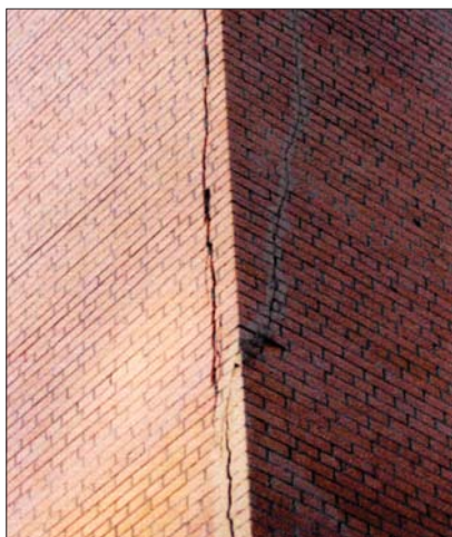
Рис. 2.3.7 ж Здание на ул. Магнитогорская в Москве. Фрагмент стены в осях 4/Г. Вертикальные и наклонные трещины в уровне четырех – шести этажей
