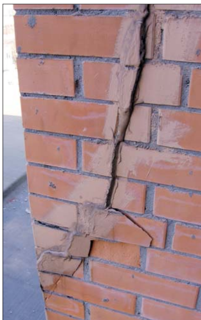
Рис. 2.3.7 и Здание на ул. Магнитогорская в Москве. Выпучивание кладки лицевого слоя на углу стены между осями 110 –120 на высоте четвертого этажа
