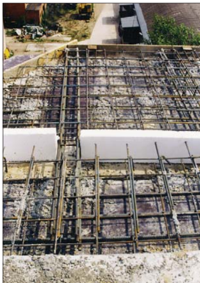
Рис. 1.1.27 а, б, в Строительство 10-этажного жилого дома с наружными стенами из многослойной кладки в г. Красноармейск Московской области, 1999 г: а - общий вид здания; б - устройство горизонтальной армированной растворной диафрагмы в наружной стене; в - устройство шпонок из утеплителя между плитами перекрытия балкона
