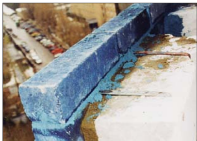
Рис. 2.5.3 Связи из обычной стали без антикоррозионного покрытия
