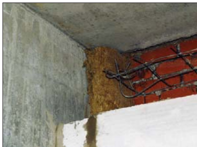
Рис. 1.1.23 г Выпуски арматуры из наружного слоя кладки для заделки во внутренний слой из ячеистобетонных камней
