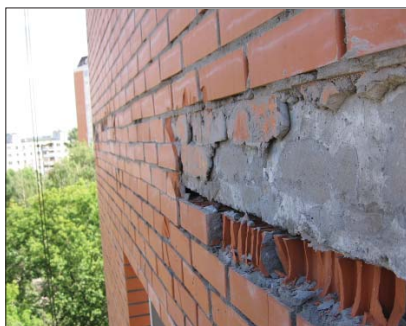
Рис. 2.3.6 д Разрушение кладки из распиленных по толщине кирпичей, облицовывающих торец плиты
