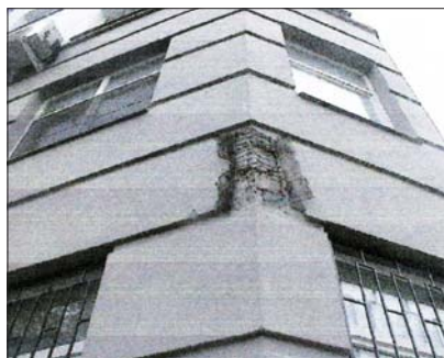
Рис. 2.5.2 в Штукатурный слой по стальной сетке в месте вскрытия
