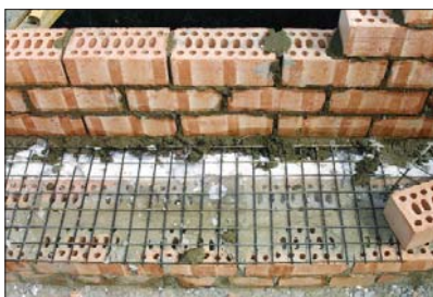
Рис. 1.1.27 а, б, в Строительство 10-этажного жилого дома с наружными стенами из многослойной кладки в г. Красноармейск Московской области, 1999 г: а - общий вид здания; б - устройство горизонтальной армированной растворной диафрагмы в наружной стене; в - устройство шпонок из утеплителя между плитами перекрытия балкона
