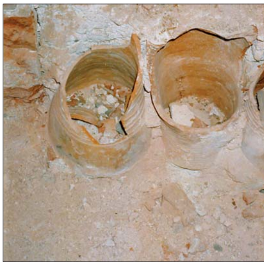
Рис. 3.1.3. Вскрытие выполненного из керамических «горшков» подстилающего слоя, установленного по кирпичным сводам в Большом Кремлевском Дворце в Москве (1996 г.)
