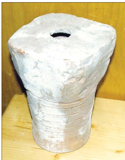
Рис. 3.1.1 Керамические пустотелые «горшки», заложенные в наружные стены Большого Кремлевского Дворца
