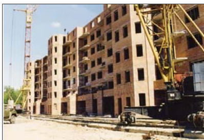
Рис. 1.1.26 Строительство 22-этажного жилого дома с наружными стенами из колодцевой кладки. Опираение внутреннего слоя стены производится на перекрытие, наружного слоя - на стальной уголок, ул. Молодоговардейская, Москва, 1999 г.
