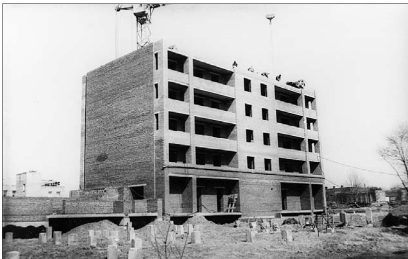
Рис. 1.1.20 Строительство экспериментального девятиэтажного жилого дома с наружными самонесущими стенами из облегченной кладки с вертикальными диафрагмами, г. Воскресенск Московской области. По техническим решениям автора, 1991 г.
