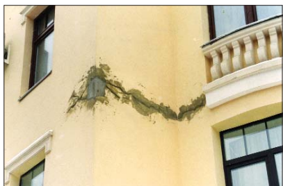
Рис. 2.5.1 в Горизонтальные трещины в уровне перекрытия
