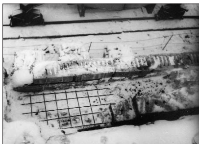
Рис. 2.2.2 Попадание снега и мусора в полость для утеплителя
