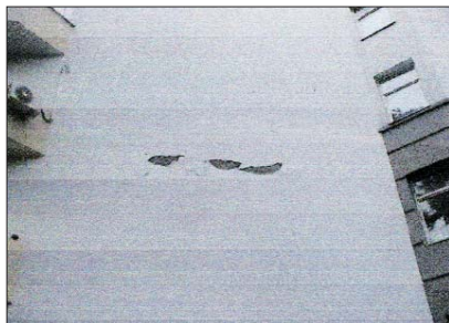
Рис. 2.5.2 г Отслоение штукатурного слоя в уровне перекрытий
