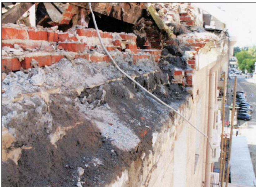
Рис. 1.1.10 Кладка наружных стен с внутренним слоем из шлакобетонных камней. Театр им. Станиславского и Немировича-Данченко, 1930-е годы. Фото автора, 2005 г.
