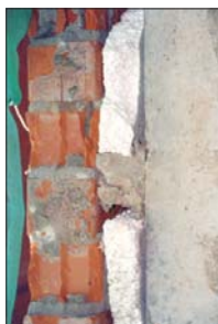
Рис. 2.2.1 а, б Пример некачественной укладки плитного утеплителя из пенополистерола в наружной стене: а – в месте примыкания наружного слоя к железобетонной колонне; б – в трехслойной кладке
