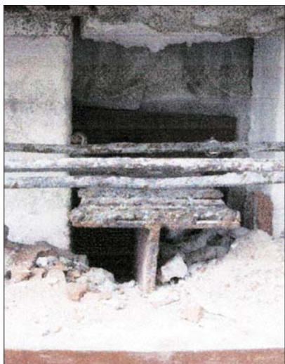
Рис. 2.3.9 в Стальные кронштейны для опирания на них кладки наружного слоя
