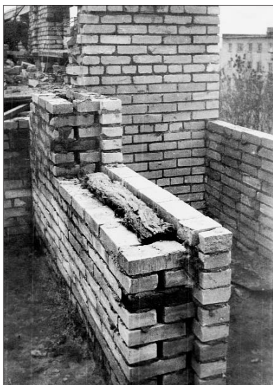
Рис. 1.1.14 Наружная стена, утепленная минераловатной плитой на пятом этаже дома в Электростали (1973 г.). [9]
