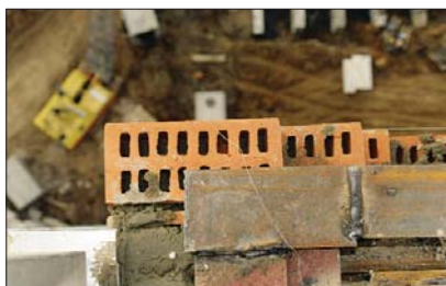
Рис. 2.3.2 Свес наружного слоя кладки на 6 см в сторону улицы, г. Москва, 1999 г.
