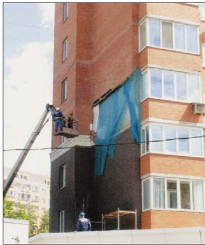
Рис. 2.3.6 б Фрагмент фасада здания на ул. Петрозаводская после обрушения кладки лицевого слоя наружной стены, 2007 г.
