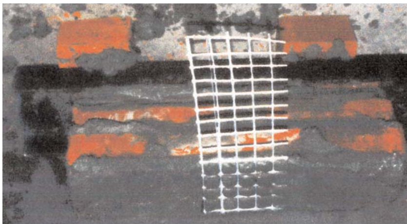
Рис. 9.2.1 г. Заделка сетки из стекловолокна в растворный шов
