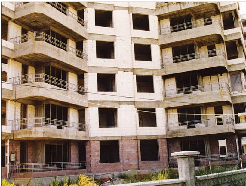
Рис. 1.1.22 а, б Здания из монолитного железобетона с наружными стенами из облегченной кладки, устанавливаемыми на перекрытия, Турция, 1997? г.: а - из керамических камней с горизонтальными пустотами; б - из ячеистобетонных камней
