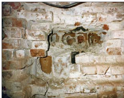
Рис. 3.1.1 Керамические пустотелые «горшки», заложенные в наружные стены Большого Кремлевского Дворца
