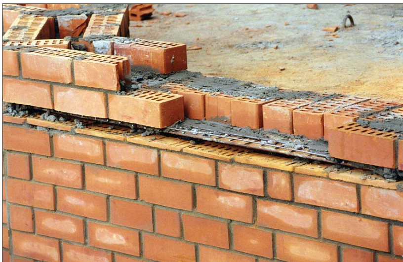
Рис. 1.1.26 Строительство 22-этажного жилого дома с наружными стенами из колодцевой кладки. Опираение внутреннего слоя стены производится на перекрытие, наружного слоя - на стальной уголок, ул. Молодоговардейская, Москва, 1999 г.
