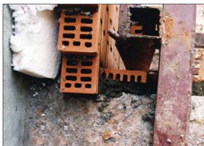
Рис. 2.3.1 Смещение несущего наружного слоя кладки в сторону улицы, исключющее устройство горизонтального деформационного шва, г. Одинцово, 1999 г.
