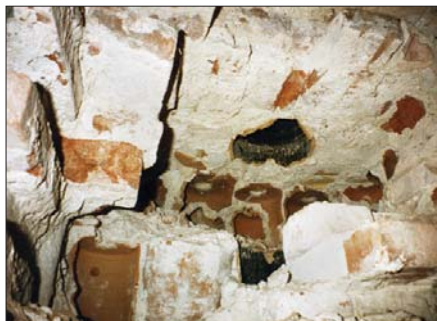
ис. 3.1.2 Вскрытие простенка наружной стены. Видна кладка из керамических горшков и дымовые каналы, обложенные керамикой. БКД в Москве, 1996 г.
