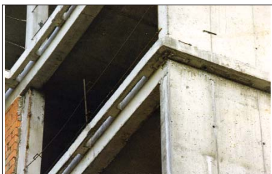
Рис. 1.1.25 а, б, в Возведение жилого дома с наружными несущими стенами из облегченной кладки, устанавливаемые на перекрытие, Рублевское шоссе, Москва, 1999 г: а - общий вид; б - балконная плита с отверстиями под утеплитель; в - железобетонные консоли с отверстиями под утеплитель для установки наружного слоя кладки
