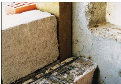
Рис. 1.1.23 в Крепление внутреннего слоя кладки из ячеистобетонных камней к внутренней стене из монолитного железобетона, г. Одинцово Московской обл.
