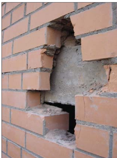
Рис. 2.3.7 е Отсутствие перевязки кладки в уровне верха плиты перекрытия
