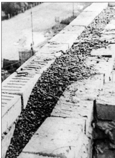
Рис. 1.1.15 Строительство пятиэтажного жилого дома серии 85 в Волоколамске. Облегченная кладка кирпичных стен, утепленных керамзитовым гравием (Волоколамское СМУ треста Мособлстрой-18) 1978 г. [9]
