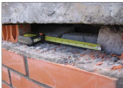
Рис. 2.2.1 в Продуваемый зазор между низом перекрытия и верхом кладки внутреннего слоя из ячеистобетонных камней (дом на ул. Петрозаводская). Фото автора, 2007 г.
