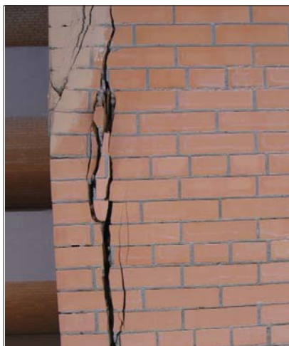
Рис. 2.3.7 з Вертикальная трещина на углу стены между третьим и четвертым этажами
