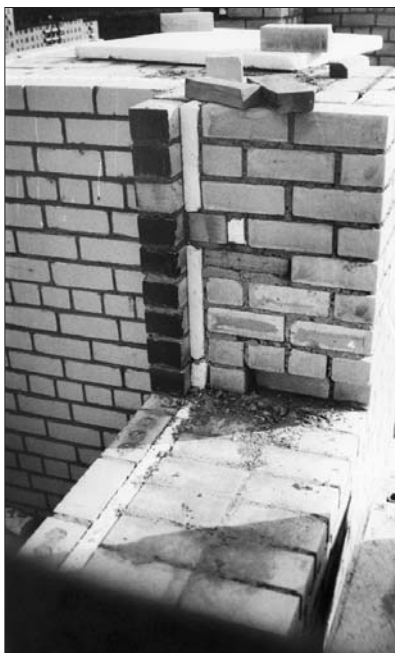
Рис. 1.1.21 Возведение первого в России жилого дома высотой 12 этажей с наружными несущими стенами с кладкой с уширенным швом, заполненным эффективным (плиты из пенополистерола) утеплителем, г. Апатиты. Техническое решение автора, 1990 г.
