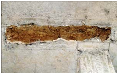
Рис. 1.1.23 е Шпонка из утеплителя между плитами перекрытия и балкона, г. Одинцово Московской области
