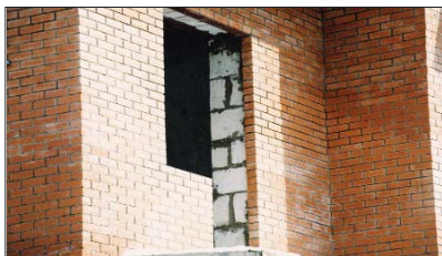
Рис. 1.1.23 а, б Строительство 15-этажного жилого дома с наружными ненесущими стенами из облегченной кладки с устанавливаемыми на перекрытие, г. Одинцово Московской области, 1998 г: а - общий вид здания; б - конструкция наружной стены из ячеистобетонных камней с облицовкой кирпичом
