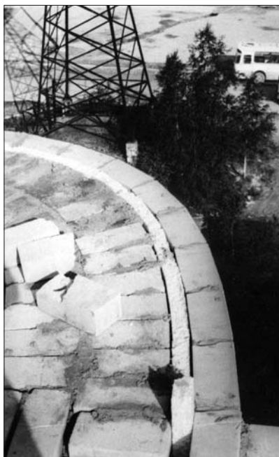
Рис. 1.1.21 Возведение первого в России жилого дома высотой 12 этажей с наружными несущими стенами с кладкой с уширенным швом, заполненным эффективным (плиты из пенополистерола) утеплителем, г. Апатиты. Техническое решение автора, 1990 г.
