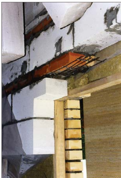
Рис. 1.1.24 а Жилой шестизэтажный дом с наружными стенами из трехслойной облегченной кладки, устанавливаемыми на перекрытия, ул. Молодоговардейская, Москва, 1999 г. Рис. 1.1.24 б Фрагменты наружной стены
