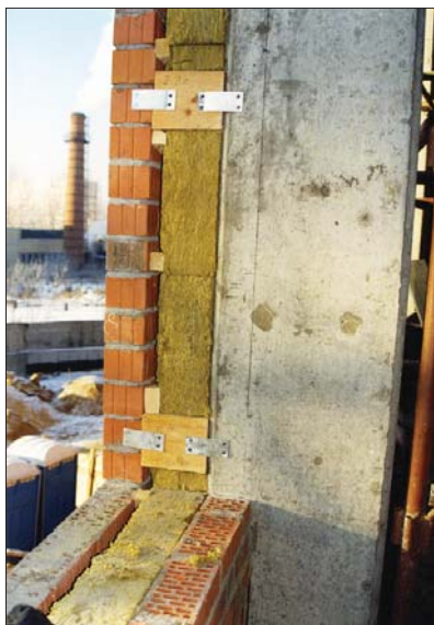
Рис. 1.1.28 а, б, в Строительство здания англо-американской школы с наружными стенами из кладки с гибкими связями, Москва, 1999 г:
