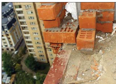
Рис. 2.3.3 Свес наружного слоя кладки со стального уголка на 15 см вместо 4-х по проекту. Москва, 1999 г.
