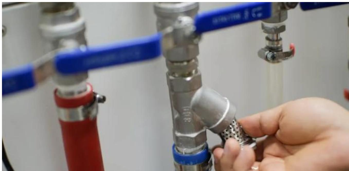
Снятие фильтра водяного охладителя
