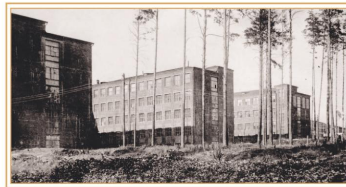
III корпус Уральского политехнического института
