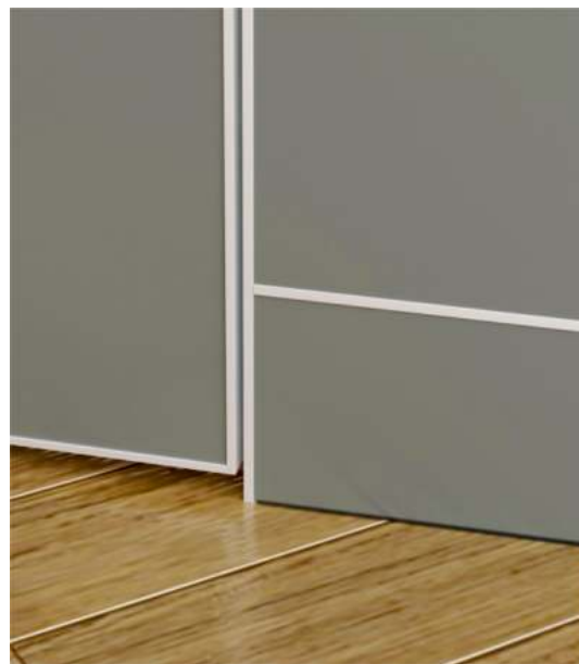
Фрагмент модели РДА 18 с плинтусом в алюминиевом профиле
