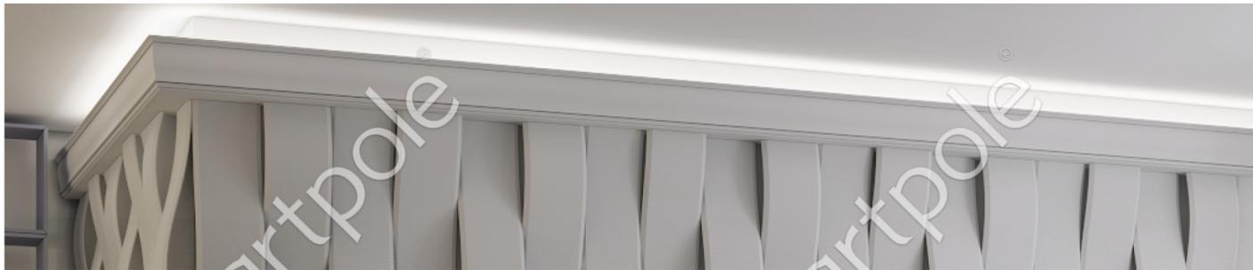
**Важно:** При монтаже короба до монтажа панелей, верхние панели, прилегающие к коробу, приставляются на сухую без клея, отмечаются на коробе карандашом метки отверстий для подключения, сверлятся отверстия в коробе, и только затем панель можно монтировать.
