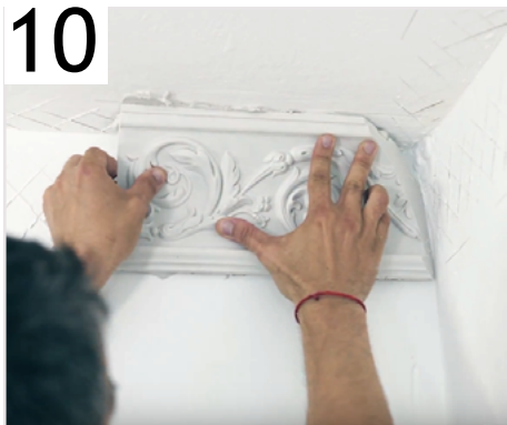
10 Приложите карниз к поверхности и прижмите на 1-2 минуты
