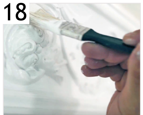
18 Нанесите финишное покрытие
