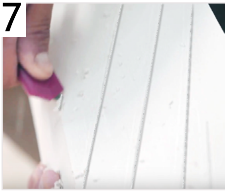
7 Сделайте насечки на карнизе с тыльной стороны
