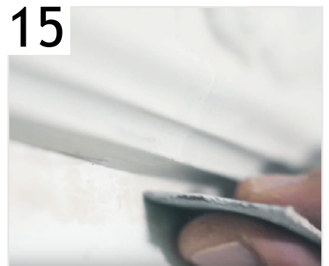
15 Через 60 минут зачистите обработанные стыки наждачной бумагой №100, а затем №300
