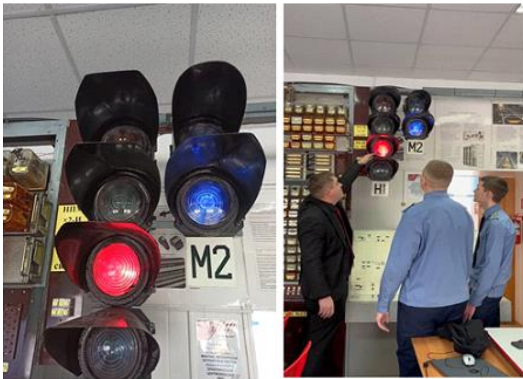
Рисунок 1. Лаборатория технического обслуживания, ремонта, монтажа, регулировки устройств и систем механической и электрической централизации ЖАТ
