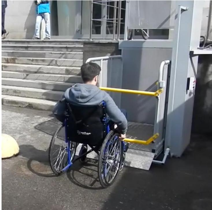
5. Для беспрепятственного въезда на грузонесущее устройство платформы производится поднятие ограждающих шлагбаумов вручную (рис. 7).
