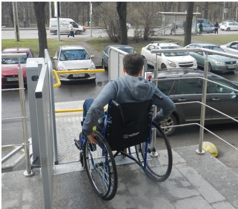
11. После съезда с платформы пользователь производит закрытие ограждающей калитки (рис.12).
