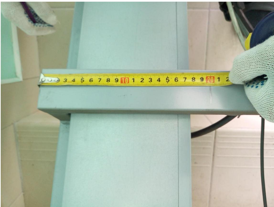
После выполнения отверстий в элементах необходимо переместить консоль в место её установки и наметить места бурения отверстий под анкера (в случае установки консоли на стену без использования вертикальных стоек).
