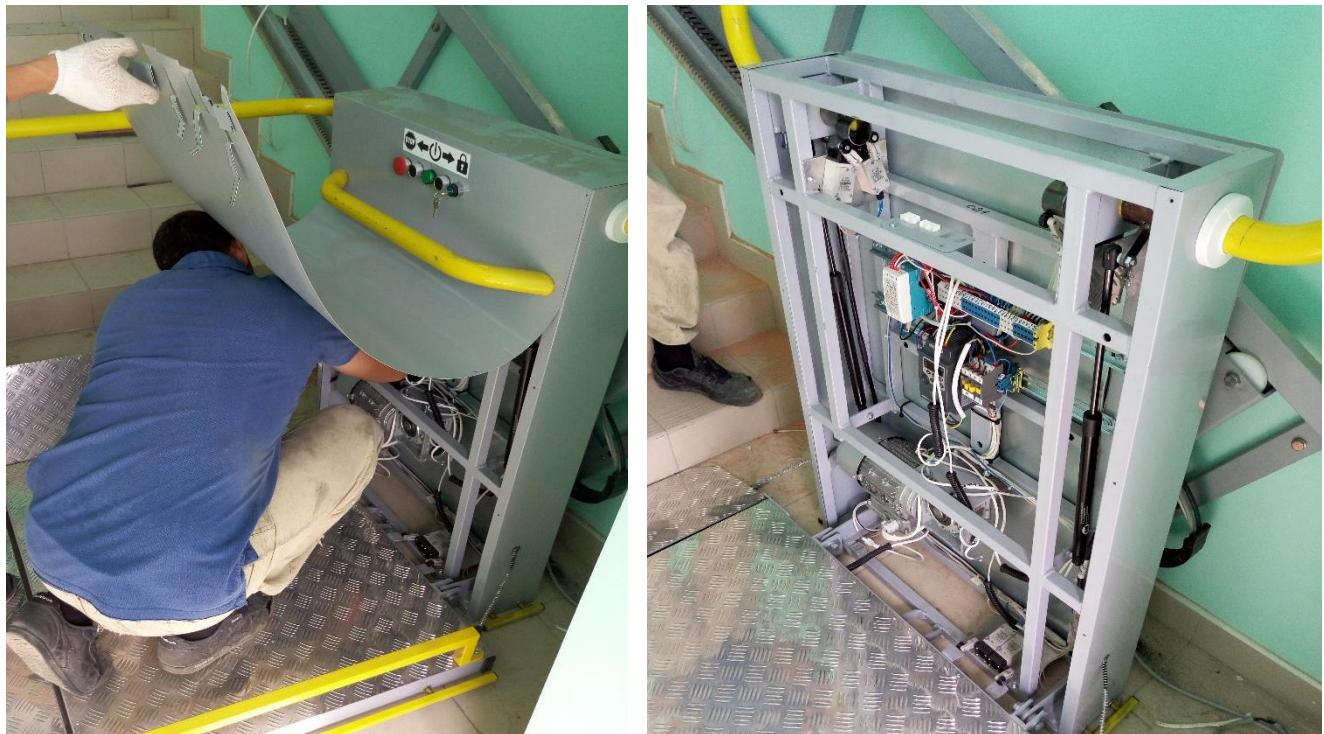
16. Установить подъемную платформу на зубчатую рейку, совместив корпус подъемной платформы с ходовой кареткой на консоли (рис.23,24). В четырех местах просверлить отверстия в каретке через заводские отверстия в корпусе подъемной платформы, предварительно удостоверившись в правильности установки строительным уровнем (рис.25). Соединить каретку с подъемной платформой болтовыми креплениями. Между кареткой и корпусом подъемной платформы установить на болтах дистанционные прокладки (рис.26).
