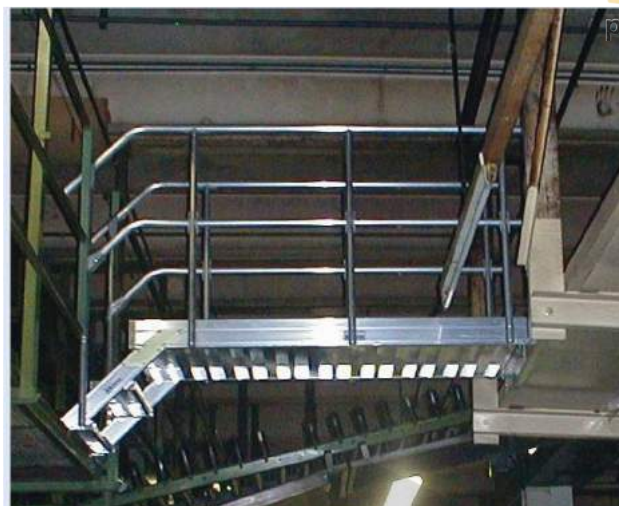
Переход между двумя уровнями
