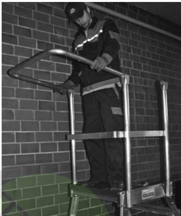
Установите защитную планку на уровне колен. Вставьте с задней стороны лестницы в предназначенные для этого отверстия перила. Выровняйте стойки перил и затяните гайки. Затяните соединения перил (20 Нм).
