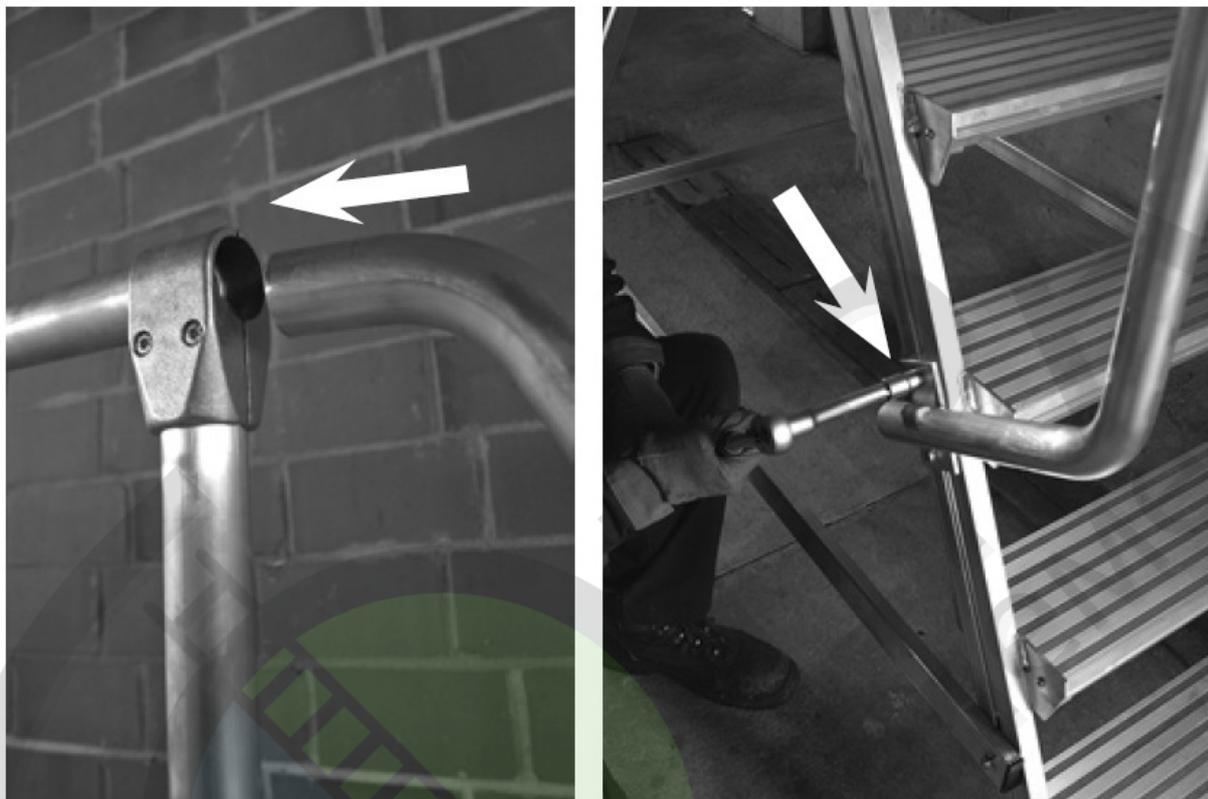
Вставьте верхний конец поручней в соединительный элемент. Затяните соединительный элемент, а также крепление внизу (20 Нм).
