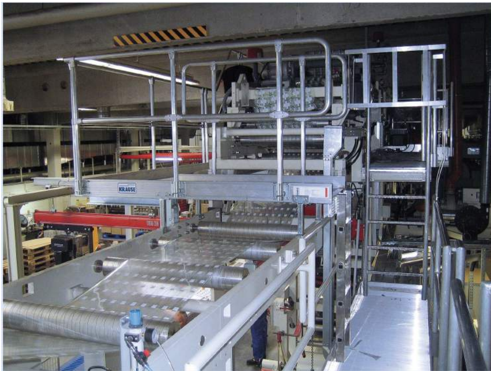
Рабочая площадка со съёмными перилами, подъем по приставной лестнице
