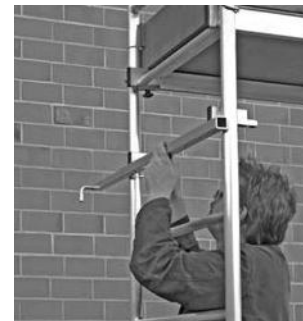
Базовая конструкция с первой надстройкой
