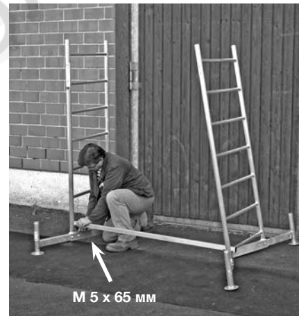
Базовая конструкция с первой надстройкой
