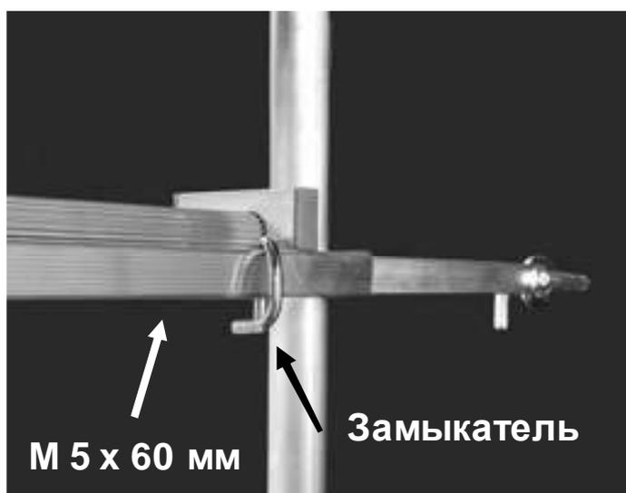
навесить якорную трубу в якорный рым-болт закреплённый на стене. Закрепить якорную крепёжную трубу к перекладине под верхним помостом.
