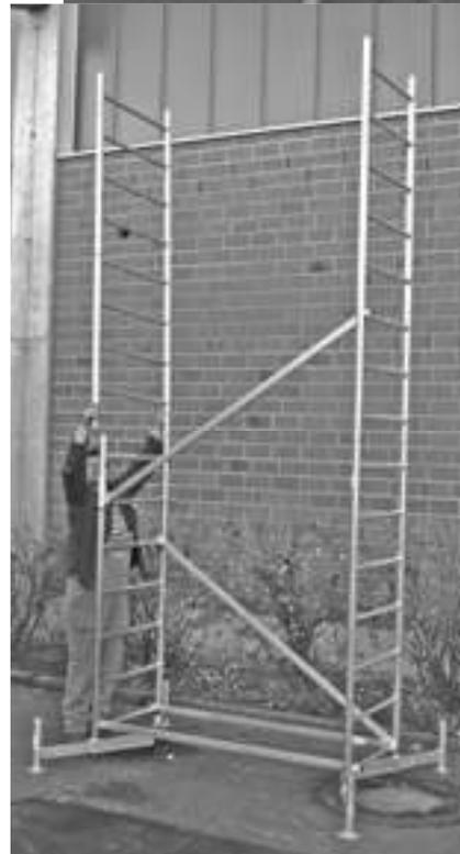
Базовая конструкция с первой надстройкой
