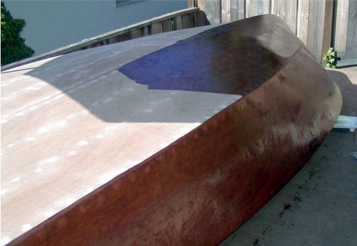
Сатурация корпуса эпоксидной смолой перед оклейкой стеклотканью. Отверстия под головки закрыты шпаклевкой под цвет древесины фанеры.
