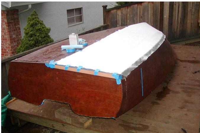
Оклейка стеклопластиком - специфическая работа, требующая средств индивидуальной защиты. Полосы стеклоткани лучше укладывать вдоль корпуса.
