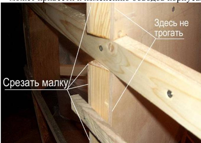
Рис 13. Врезка стрингеров и малковка набора. Грубую малковку можно произвести электрорубанком, а окончательную только ручным рубанком.
