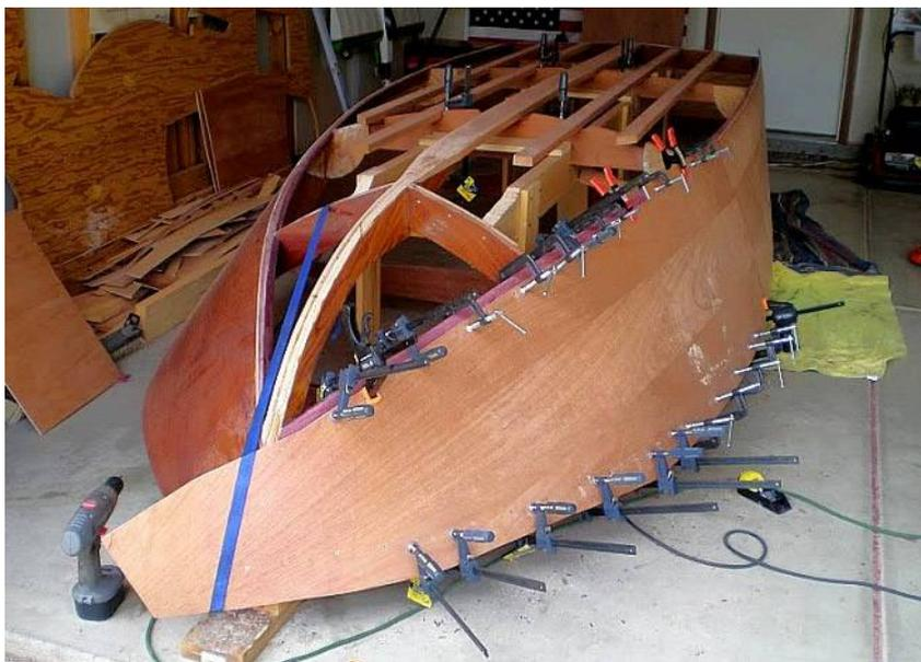
Стыковку фанерных деталей выполняют встык с подкладкой изнутри из той же фанеры. Ширина подкладки 20 толщин. Подкладные планки укладываются изнутри корпуса плотно между стрингерами и прижимаются к обшивке шурупами и на клею в районе стыка листов обшивки.
