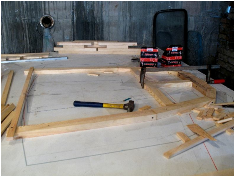
Рис.3 Сборка тимберсов в рамный шпангоут на плазе
