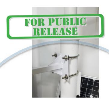
5. Закрепите основание кронштейна на опоре/стене
