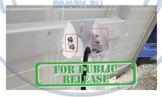
2. Закрепите соединение/крепление солнечной панели с кронштейном с помощью винтов
