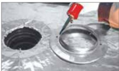
– Для повышения герметичности соединения фланца с пароизоляционным материалом нанесите Мастику герметизирующую ТЕХНИКОЛЬ №71. Мастику удобнее наносить змейкой из картриджа.
