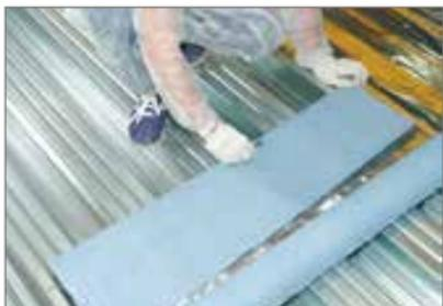
– С помощью кровельного ножа надрежьте с нижней стороны материала защитную пленку на расстоянии 30-40 см от края рулона.
