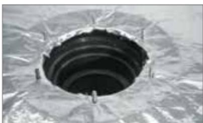
– Прорежьте кровельным ножом пароизоляционный слой по внутреннему диаметру воронки.
