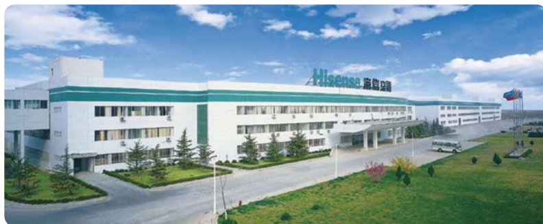
Hisense (Shandong) Air Conditioner Ltd., г. Циндао
