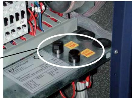
В двух моделях, как с восходящим потоком, так и с нисходящим потоком защитные термостаты TSR и TSRA доступны для ручного сброса тревоги сопротивления внутри электрического щитка в правом нижнем углу.
