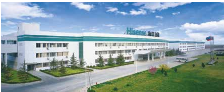
Hisense (Shandong) Air Conditioner Ltd., г. Циндао
