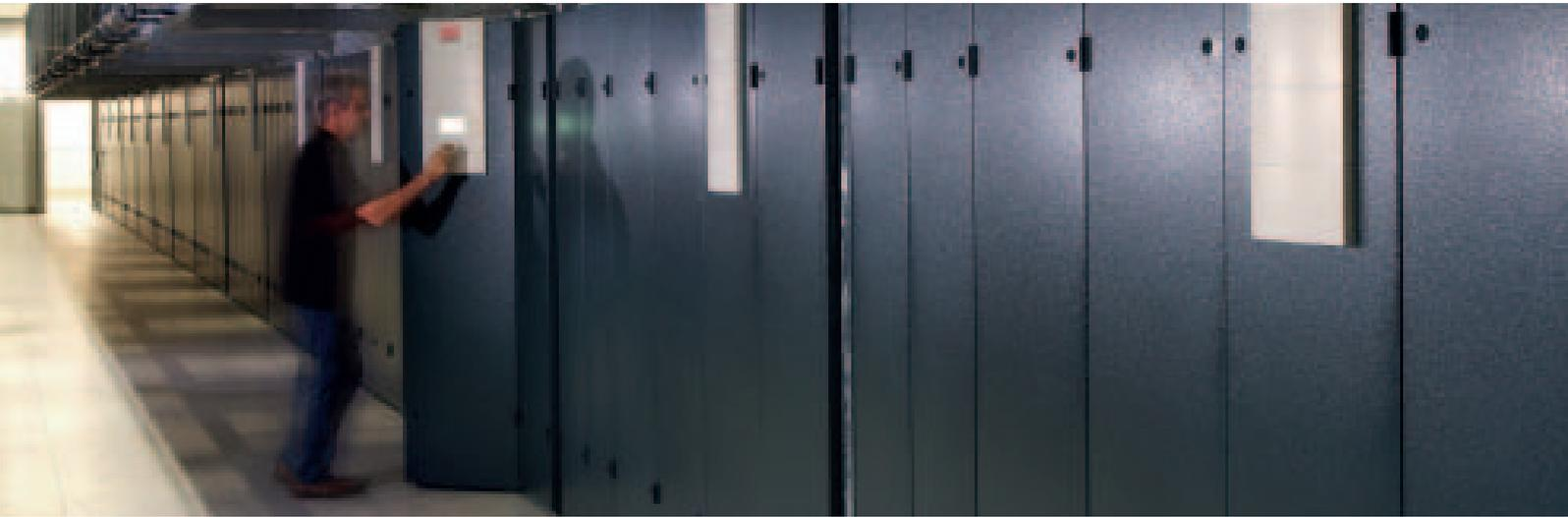
В системе STULZ CyberAir 3 возможно как централизованное, так и распределенное расположение блоков кондиционирования воздуха. Каждый блок оборудован собственным интеллектом. Возможна совместная работа в системной сети до 20 блоков.
