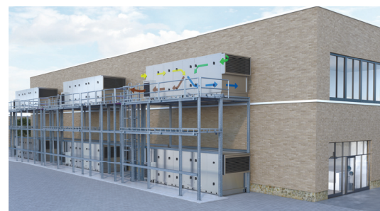
Параллельный монтаж для многоэтажных зданий
