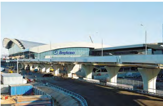
Аэропорт «Внуково», г. Москва Вентиляторы дымоудаления
