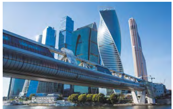
БЦ Москва-Сити, башня «Федерация», Москва Фэнкойлы Systemair
