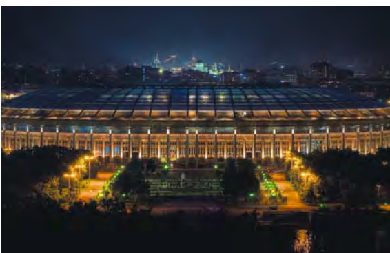
Спорткомплекс «Лужники», Москва Воздушные завесы, бассейновые агрегаты
