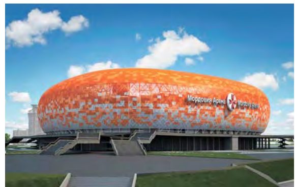
Спорткомплекс «Мордовия Арена», Саранск Вентиляторы, воздушные завесы
