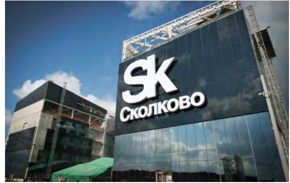
Технопарк «Сколково», Москва Воздухообрабатывающие агрегаты, вентиляторы
