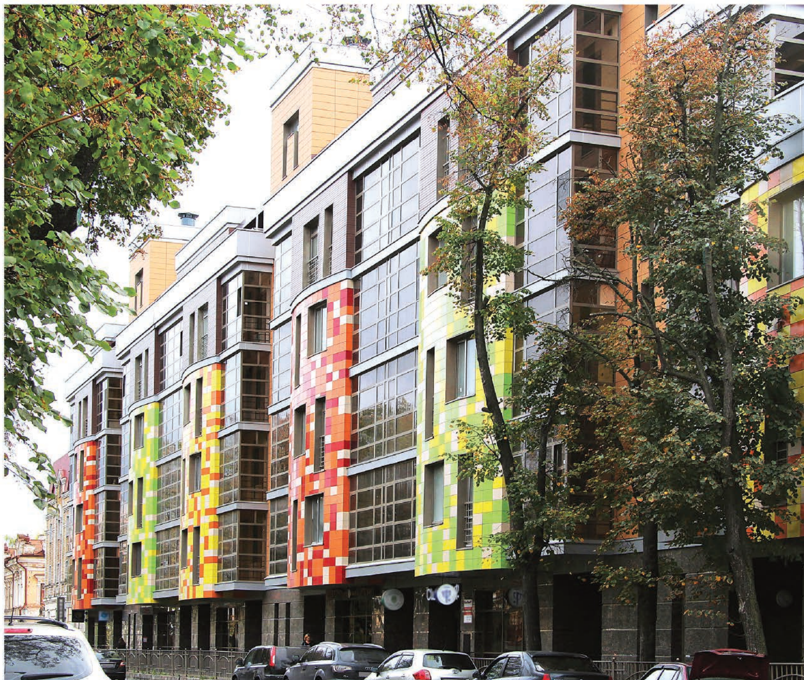
ЖК «КАСКАД» г. Казань, ул. Муштари, д. 17, 19
