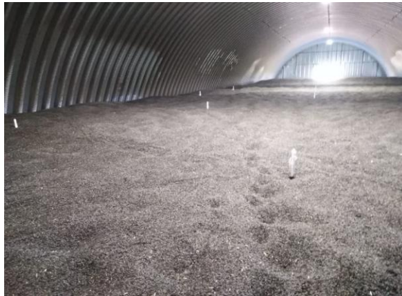
Рис. 1 Беспроводные термостанги и коллектор данных, установленные в зерноскладе
