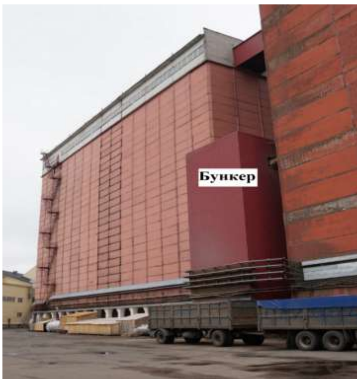
Рисунок 2 – Бункер для сбора зерновых отходов расположенный на территории элеваторного комплекса
