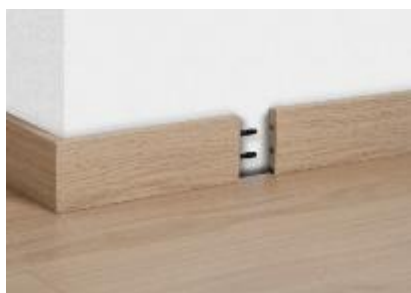
Соединение двух плинтусов вдоль стены
