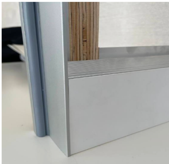
пример стыковки скрытого плинтуса со сплошной вставкой со скрытым коробом
