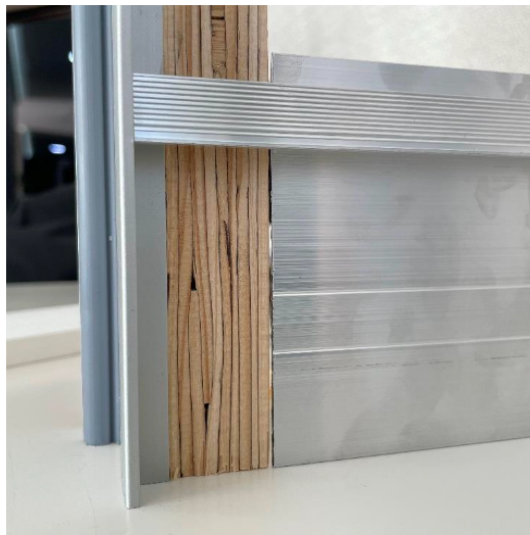
пример стыковки скрытого плинтуса со сплошной вставкой со скрытым коробом
