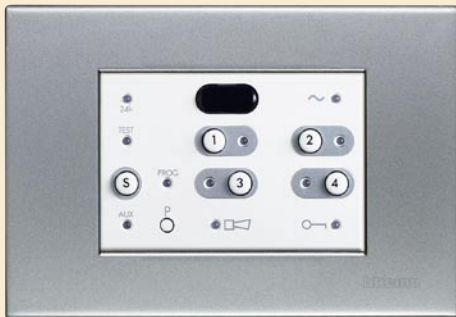
Установка блока управления Охранной сигнализации в коробку арт. 503E
