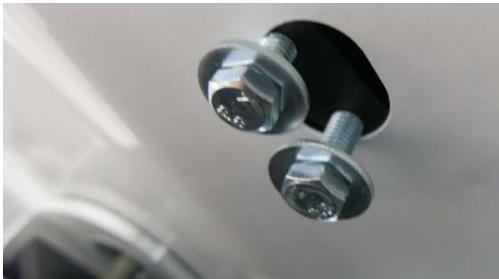
5. Придерживая закладную гайку за болт вкрутить в неё на 4-6 оборотов второй болт M6x20 с шайбой 6 (рис.5). Развернуть закладную гайку на 90 град.
