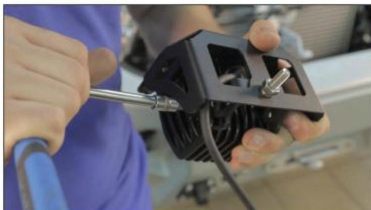
25. \*Установить фонари(поз.30) на кронштейны (поз.3). Выровнять фонарь относительно кронштейна по горизонтали и вертикали. Протянуть соединения.
