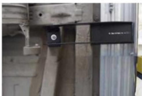
Рис.6 Установка среднего кронштейна
