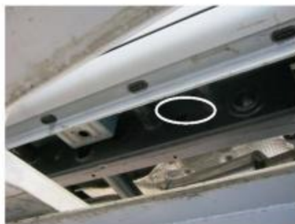
Рис.3 Установка шпильки закладной для среднего кронштейна
