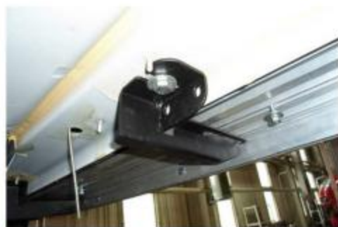
Рис.7 Установка среднего кронштейна
