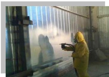
**КЕРАМОИЗОЛ** может наноситься на металлическую, бетонную, кирпичную, деревянную, пластиковую, картонную и некоторые другие поверхности (исключение - полиэтилен).
