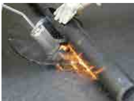
4. Наклеить 2-й слой гидроизоляции (до обжимного фланца)
