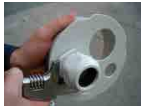
3. Установить и зафиксировать кабельные вводы.
