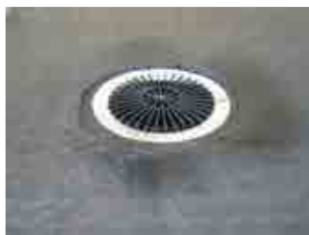
5. Так должна выглядеть воронка после укладки гидроизоляции
