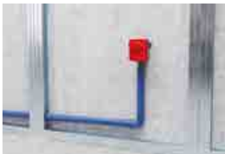
2. Соединить выпуск корпуса сифона с системой канализации.
