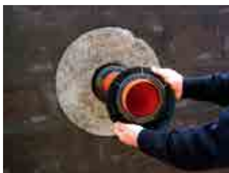
4. Установить фиксирующую гайку
