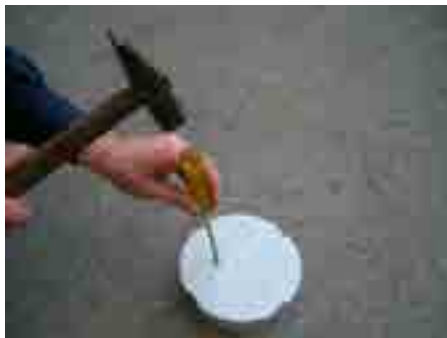
2. В монтажном элементе подготовить отверстия нужного диаметра
