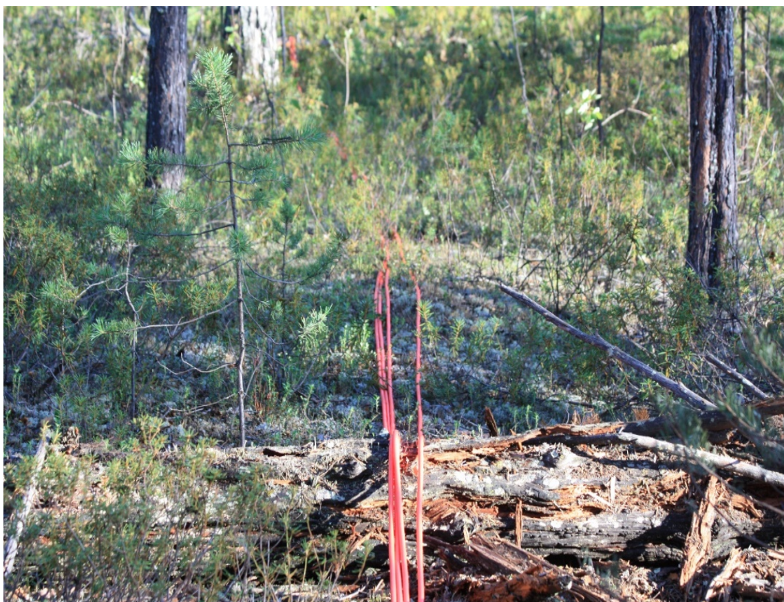
а) – прокладка линии подрыва
