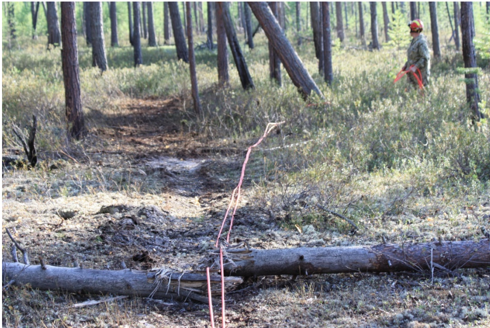
а) – прокладка детонирующих шнуров по минерализованной полосе
