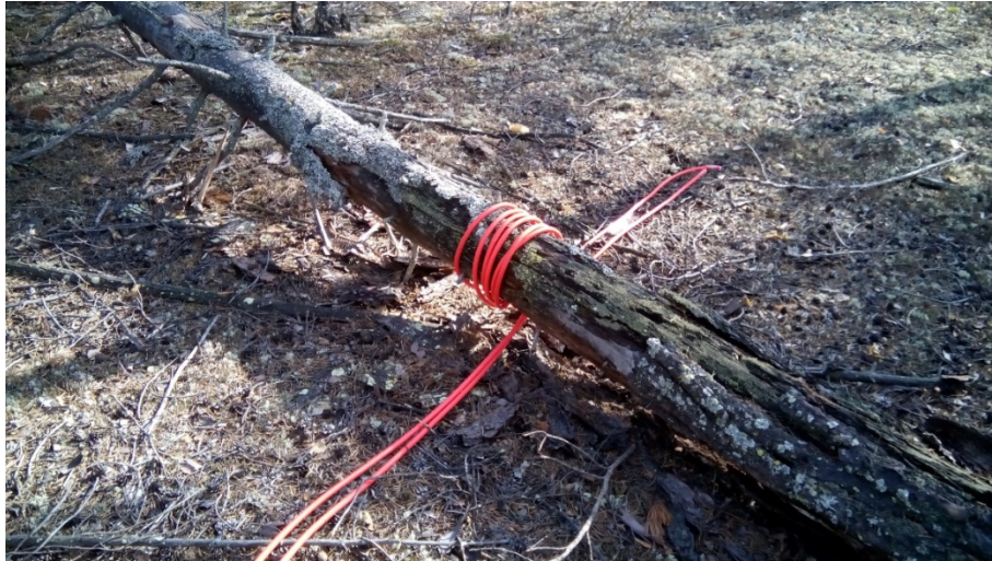
Рисунок 2.9 – Прокладка детонирующего шнура ДШН 80 при наличии поваленных деревьев
