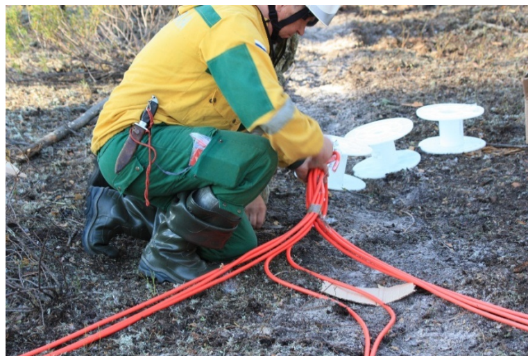
Рисунок 2.10 – Соединение нескольких линий детонирующего шнура ДШН-80 скотчем
