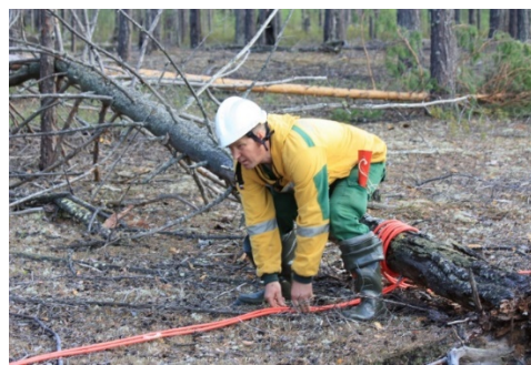
б) Прокладка шнуровой линии
