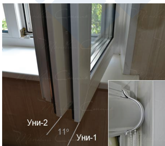
Рис 5. Степень открытия створки с UNI-1 и UNI-2
